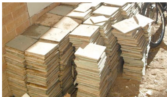
Recycling: Selbst Bodenplatten werden sorgfältig rausgelöst und anschliessend versteigert. Foto jm
